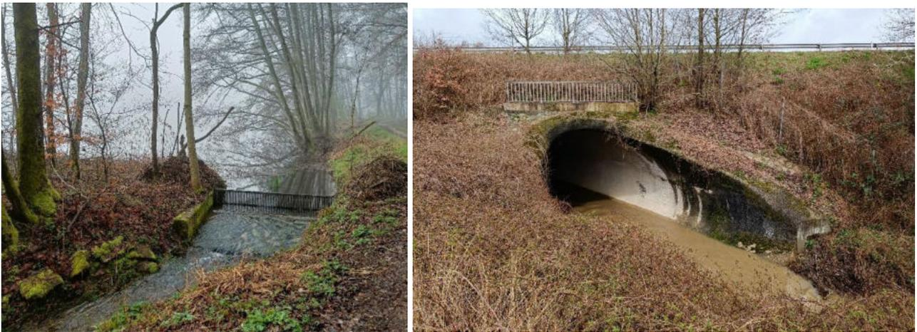
**Figure 64** : Grille en sortie d'étang à Pfterterhouse (à gauche) et passage busé du Soultzbach sous l'A36 à Diefmatten (à droite)
