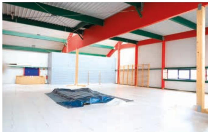
Le programme validé en décembre 2022 et démarré à l'automne 2023 a pour but le remplacement, le renforcement et la réparation de la structure de la charpente en bois. La mise en place d'habillages de protection sur les encadrements des baies vitrées et sur les parties extérieures de la charpente complètent cette réhabilitation.
