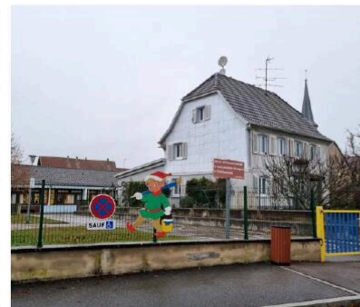
L'école maternelle de Dannemarie va être rénovée. Photo archives Morgane Schertzinger
